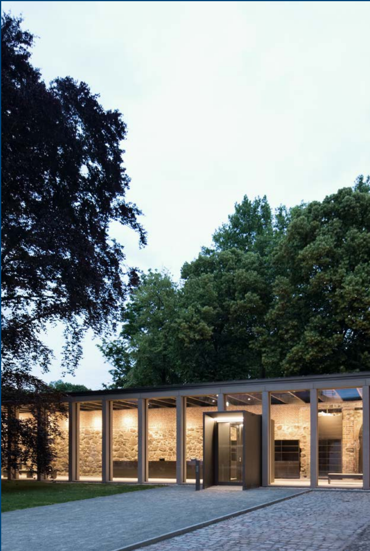
/ Neues Eingangsgebäude schafft barrierefreie Zugänglichkeit – Augusteum Wittenberg (BHBVT Gesellschaft von Architekten mbH, Gewerkdesign, Birgit Schlegel)
